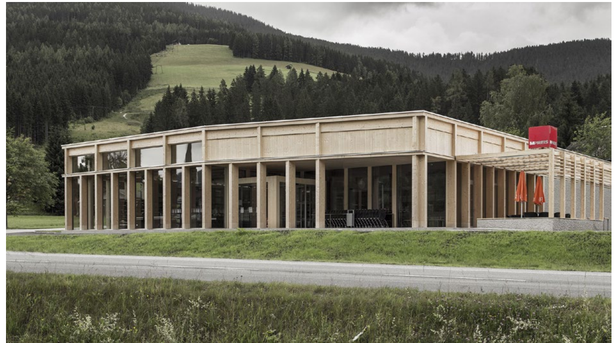
Über die Fensterfront und ein Lichtband zwischen dem Holztragwerk gelangt Tageslicht ins Innere des Ladens. Fotos: Albrecht Imanuel Schnabel
