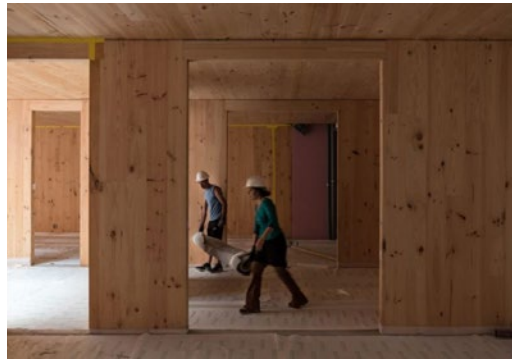
Innenausbauten in einigen der 28 Wohnungen. Fotos: LaCol Arquitectos
